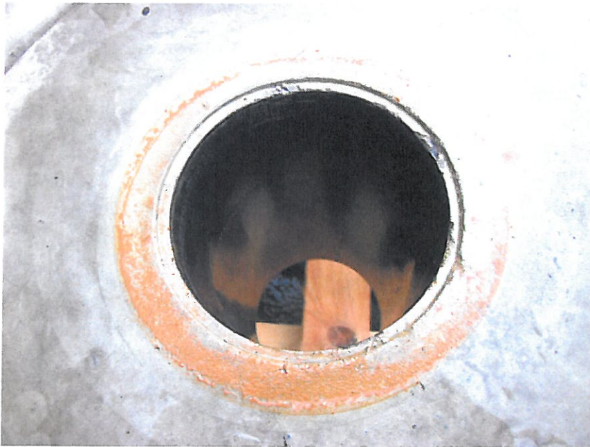
Abbildung 5: Ansicht - Oberseite des Versuchsaufbaus; einbetoniertes beschichtetes Futterrohr ZVR DN 100
