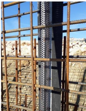
L'utilisation de la tôle CEMFLEX VB est couverte par l'ETA n°16 /0601 (European Technical Assessment) et le DTA 3.3/19-1006\_V1 (CSTB) qui garantissent l'étanchéité en reprise de bétonnage jusqu'à des pressions de 2 bars, soit 20m de pression d'eau.
