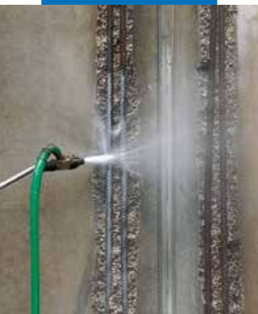
Décapage des fers par hydrosablage
