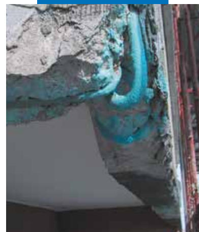
Armatures d'une allège de balcon traitées avec Mapefer 1K
