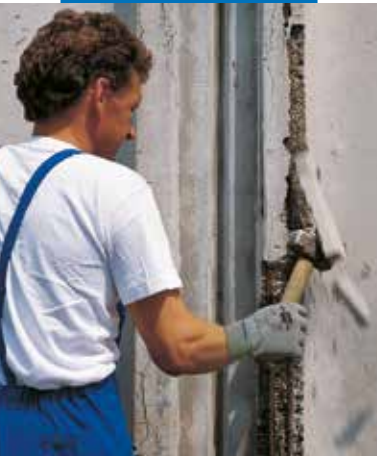
Démolition du béton dégradé
