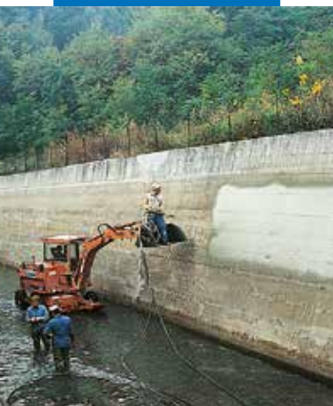
Planiseal 88 wordt in een kanaal voor hydro-elektrische energieopwekking gespoten
