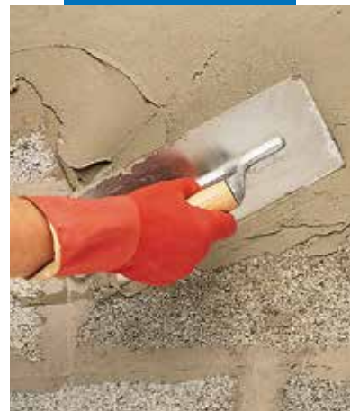
Met een spaan aanbrengen van Planiseal 88
