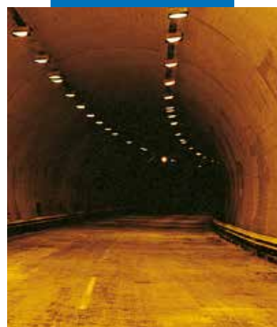
In een verkeerstunnel opspuiten van Planiseal 88 wit
