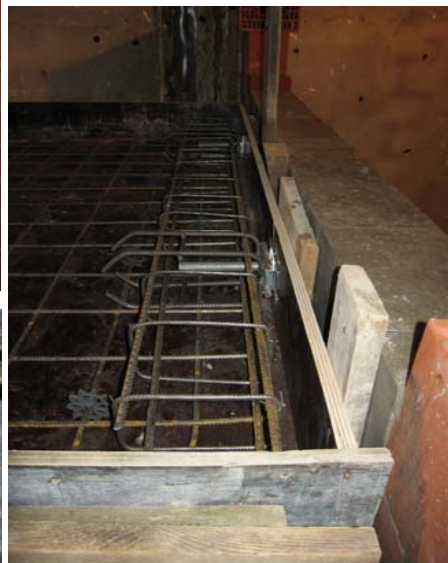
Mise en place des 2 goujons acoustiques
