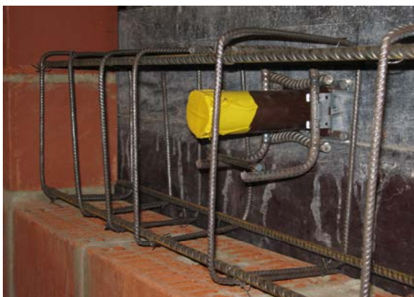
Mise en place des 2 goujons acoustiques
